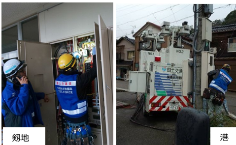
避難所への給電接続作業 (輪島市 劔地、浦上、道下、港)
