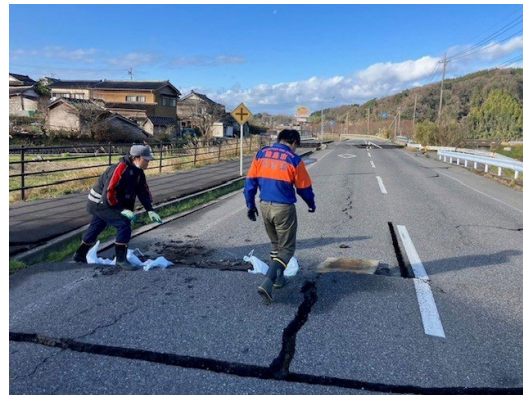
【輪島市消防団による亀裂の入った道路補修の様子】
