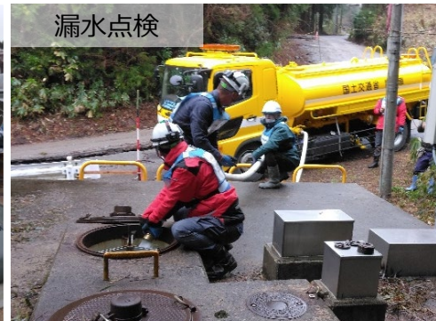
漏水点検 輪島市清土ポンプ場 配水管漏水調査
