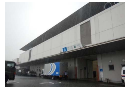
【広域物資拠点の搬出入口】
