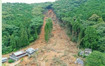
山腹崩壊による人家等の被害
