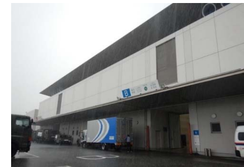
【広域物資拠点の搬出入口】
