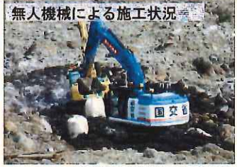
無人機械による施工状況
