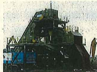
仮設の破碎・選別装置
