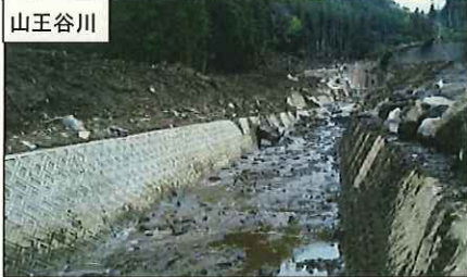
山王谷川 流路閉塞土砂掘削状況(4月25日完了)
