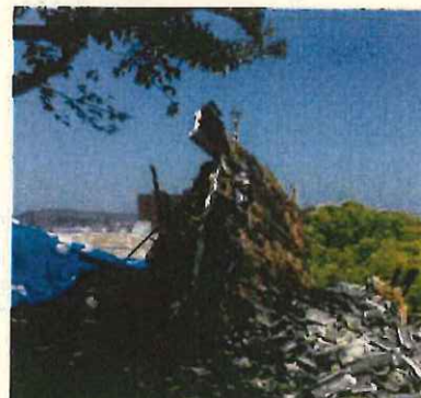
全壊した櫓が石垣下の神社を損傷
