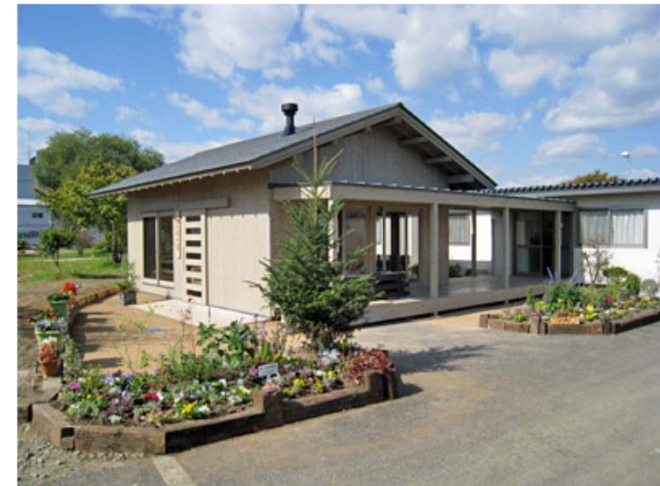
熊本県からの支援により福田町南一丁目公園仮設住宅団地に設置された“みんなの家”
