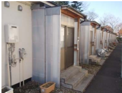
歩行者通路のアスファルト舗装
