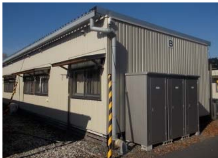
雨樋及び物干し部庇の取付け
