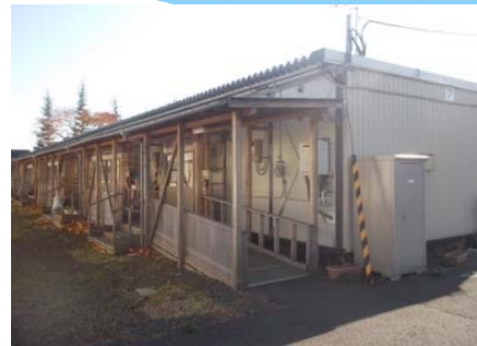
玄関庇の取付け
