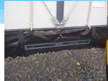
換気口取付け
