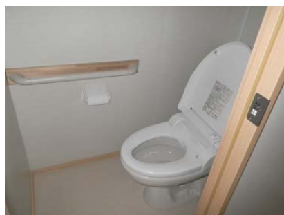
暖房便座の設置
