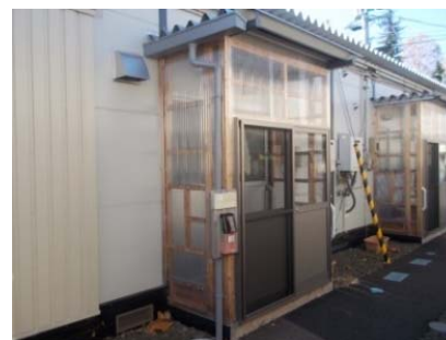
風除室の設置
