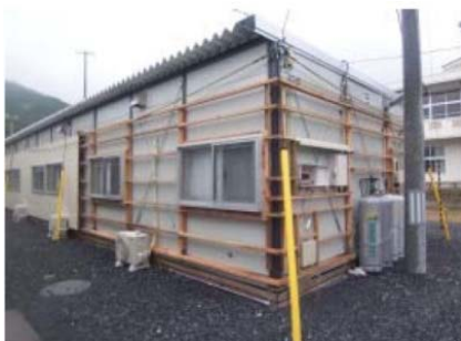
外断熱による断熱材(50mm)の追加
