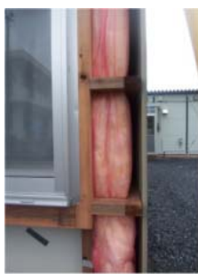
外断熱による断熱材(50mm)の追加
