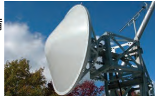
地上系通信設備 (多重無線設備)
