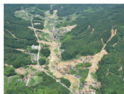
平成30年7月豪雨による 広島県呉市安浦町周辺の被災状況 (提供:国土交通省)
