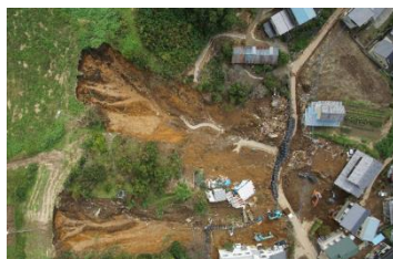
令和元年東日本台風 地すべりによる被災状況 (群馬県富岡市)
