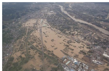
令和元年東日本台風 千曲川堤防決壊による浸水状況 (長野県長野市)
