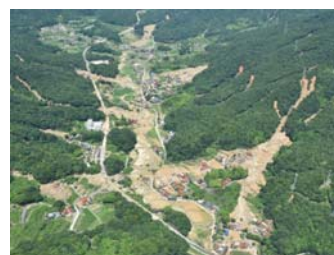
H30.7豪雨による 広島県呉市安浦町周辺の被災状況 (提供:国土交通省)
