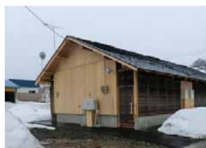
基礎を敷設した 応急仮設住宅の例
