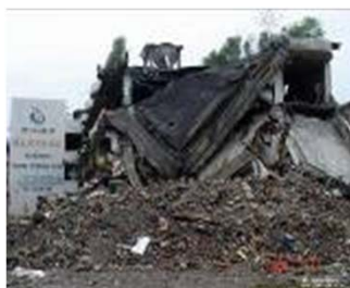
四川大地震で倒壊した建物 (中国四川省・都江堰市)
