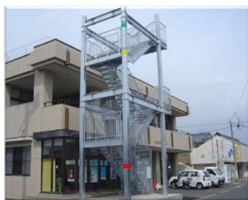
津波避難ビル外部階段の整備
