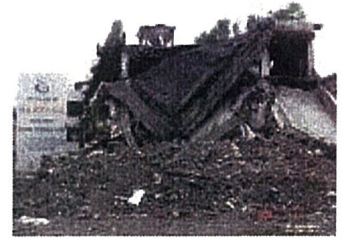
四川大地震で倒壊した建物 (中国四川省・都江堰市)
