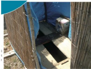
仮設トイレが到着するまでの間、避難所生活者のために作られた素掘りのトイレ 写真：日本トイレ研究所
