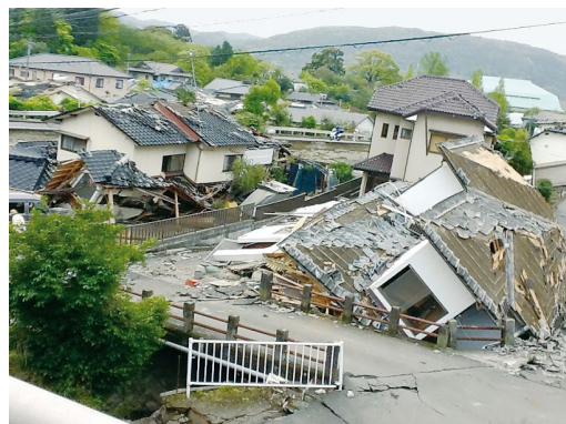
益城町における家屋倒壊の状況 (高松市消防局提供)
