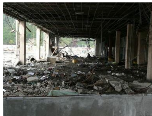
大槌町役場庁舎内部
