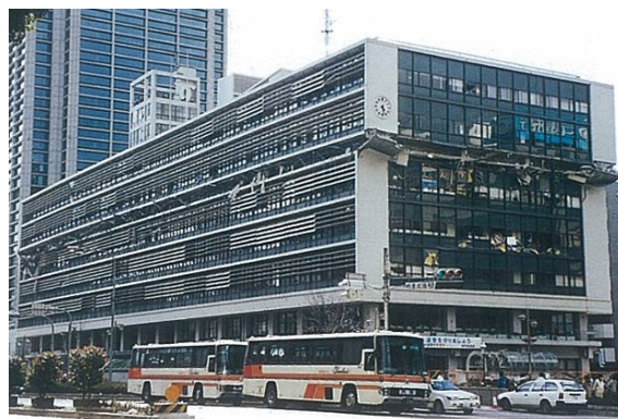
阪神・淡路大震災における神戸市役所の庁舎被害
