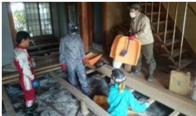
ボランティア活動の様子 Volunteer activities on site
