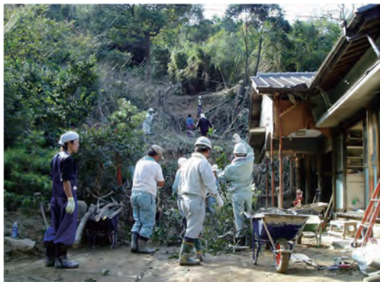
家屋周辺の泥だしをしている様子(福井県) 写真提供: 特定非営利活動法人みえ防災市民会議
