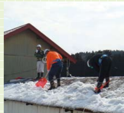
地域住民による屋根の雪下ろし
