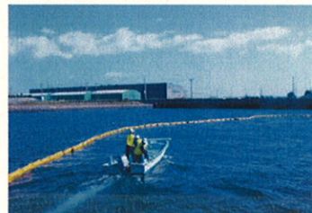
作業船によるオイルフェンスの展開包囲
