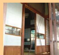
耐震補強工事の一例
