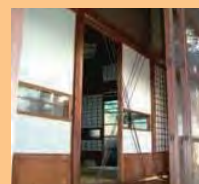
耐震補強工事の一例
