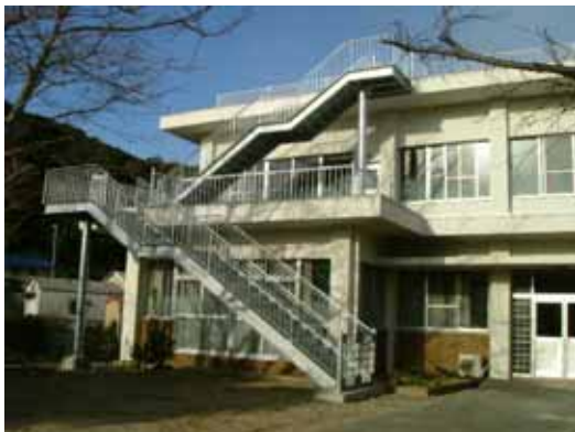
< 外部階段設置 >
