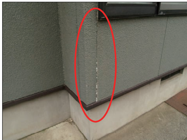
ボードの目地部にわずかなずれが生じている。
