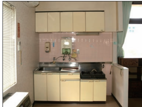
(台所の流し台：配管が破損し水やガスが使えない。)
