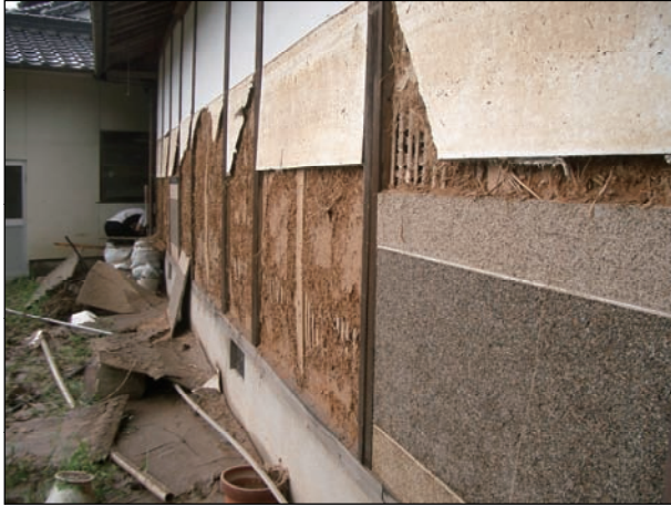
仕上材が脱落しており、下地材にひび割れが生じている。
