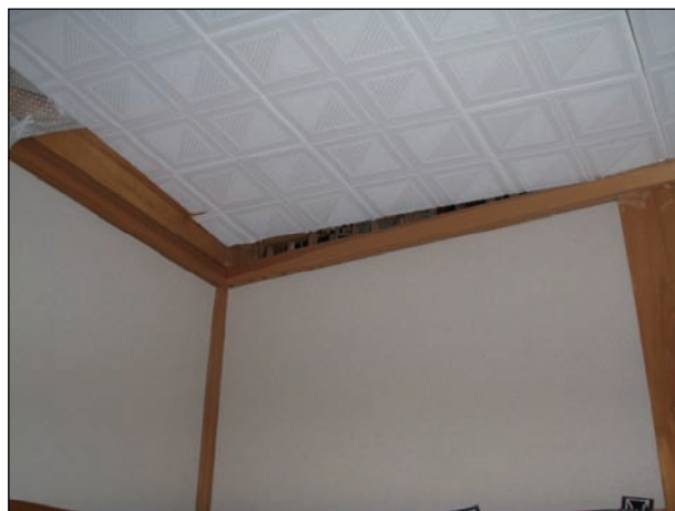
天井板の浮きが生じている。
