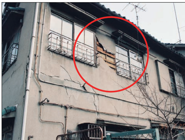
仕上材が脱落している。
