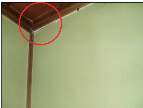
内壁周辺部に隙間が生じている。
