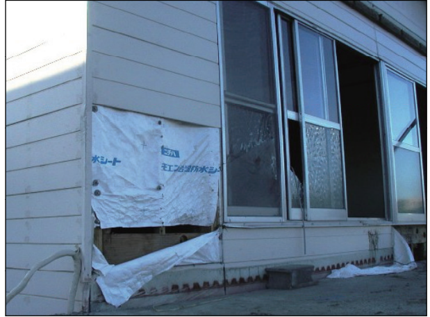
釘の浮き上がり、ボードの脱落が見られる。
