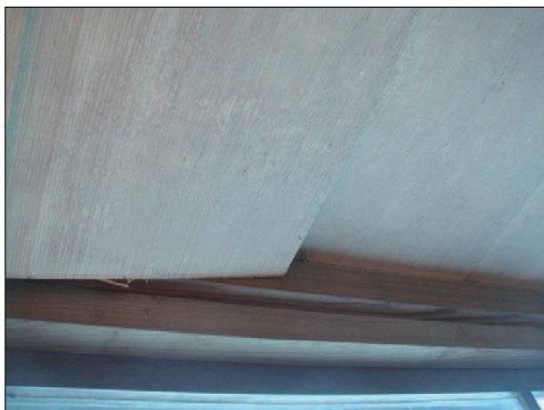
天井板の浮きが生じている。
