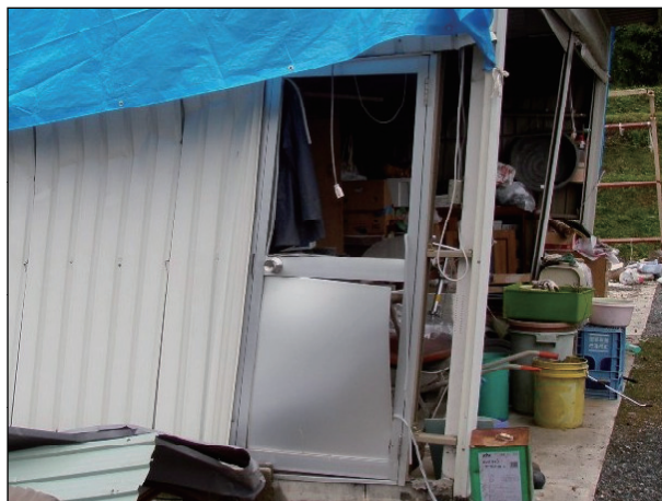
【アルミドア】 破壊されている。
