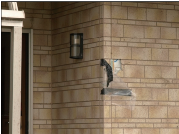
壁に飛来物の軽微な衝突痕がある。
