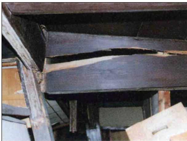
柱、梁に大きな割れが見られる。
