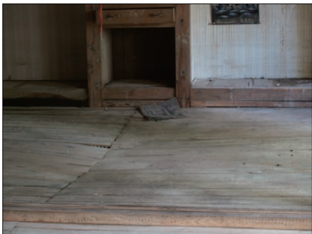
床板に著しい不陸、折損が見られる。
