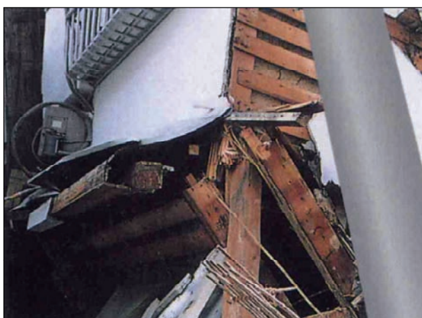
柱、梁の割れ、断面欠損が著しい。
