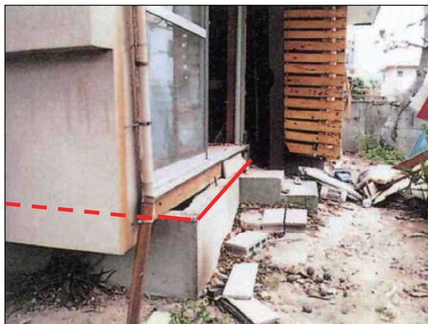
土台が基礎から著しくずれている。
