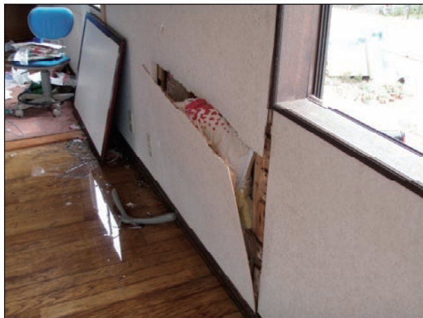
内壁合板に剥離、脱落が見られる。
