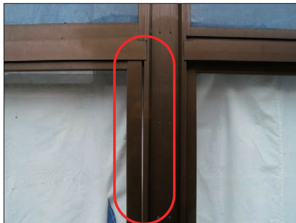
【アルミサッシ】 可動部、鍵にわずかな変形が生じ、開閉が困難になっている。
