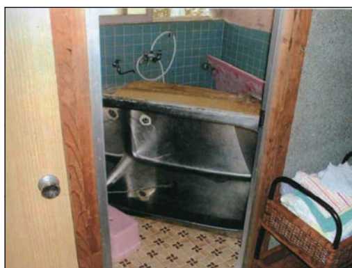
(浴槽：転倒し、配管が切れている。)
