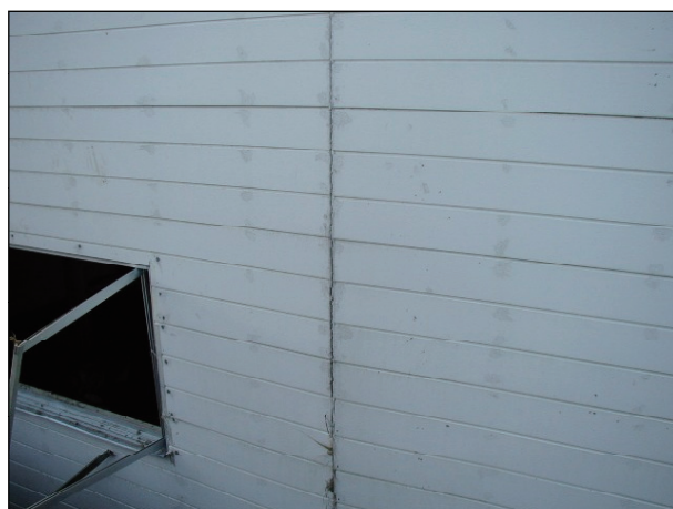
仕上面の目地部にひび割れやずれが生じている。
