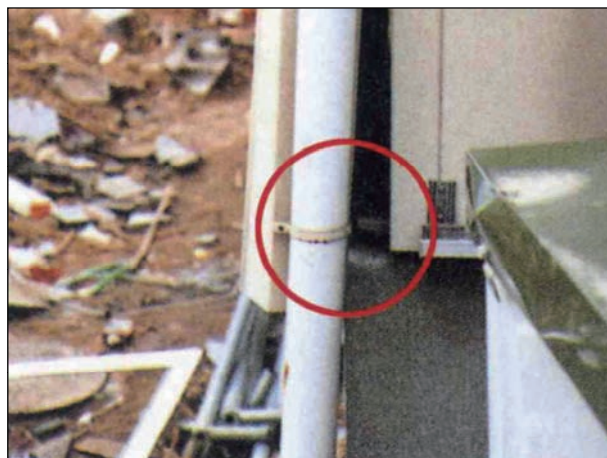
アンカーボルトの伸びが見られる。
