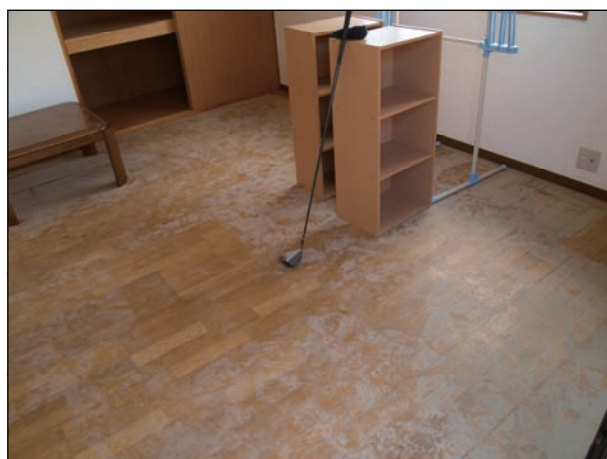
浸水により床板の汚損が見られる。
