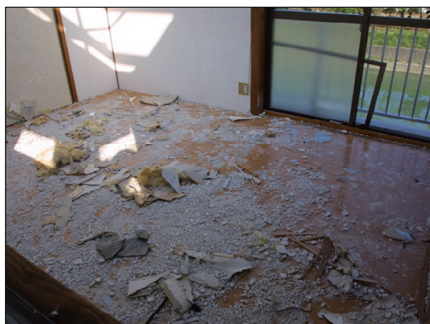
浸水により床板の汚損が見られる。
