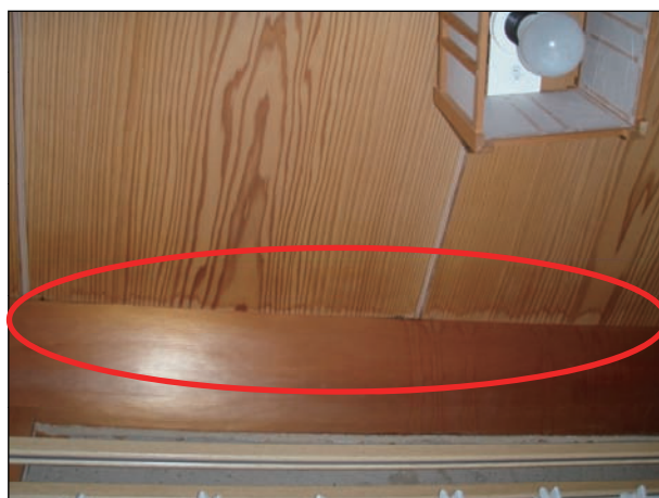
天井板に隙間が生じている。
