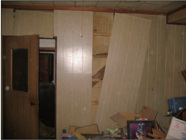
内壁合板に剥離、脱落が見られる。
