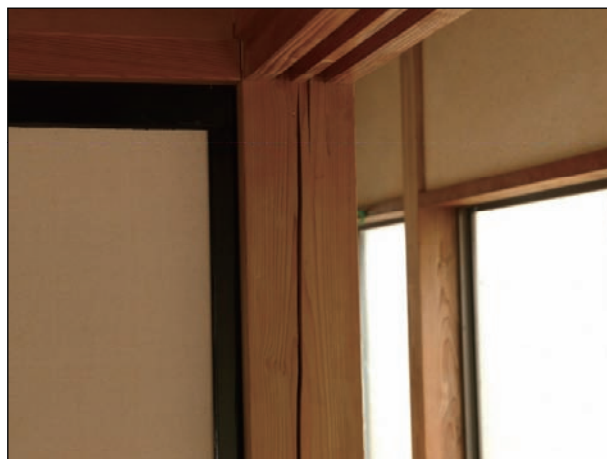
柱、梁に割れが見られる。
