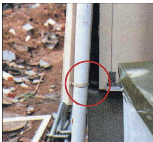
アンカーボルトの伸びが見られる。
