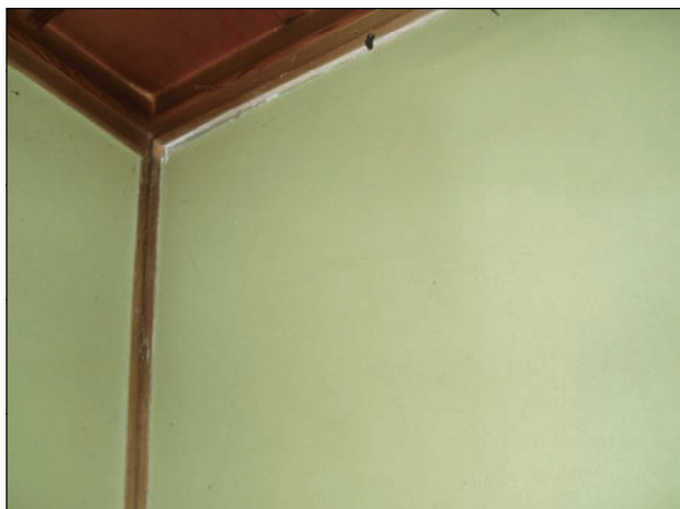
内壁周辺部に隙間が生じている。
