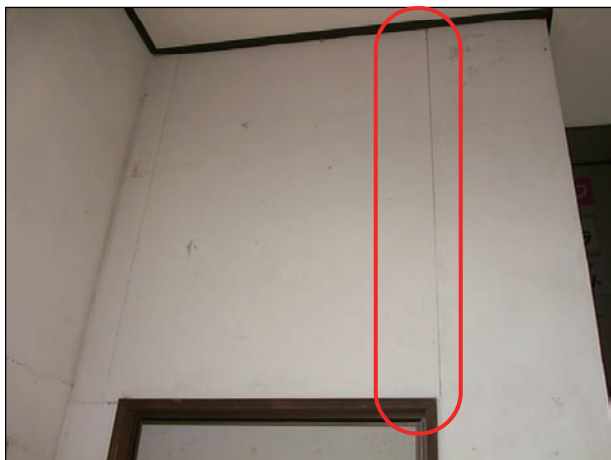
【内部仕上】 ボードの目地部にわずかなずれが生じている。
