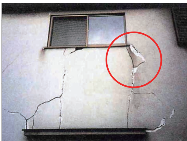
仕上の剥離が生じている。
