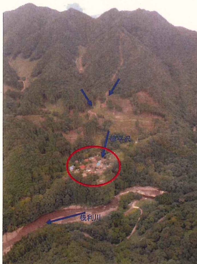
土石流の発生した柿平沢全景
