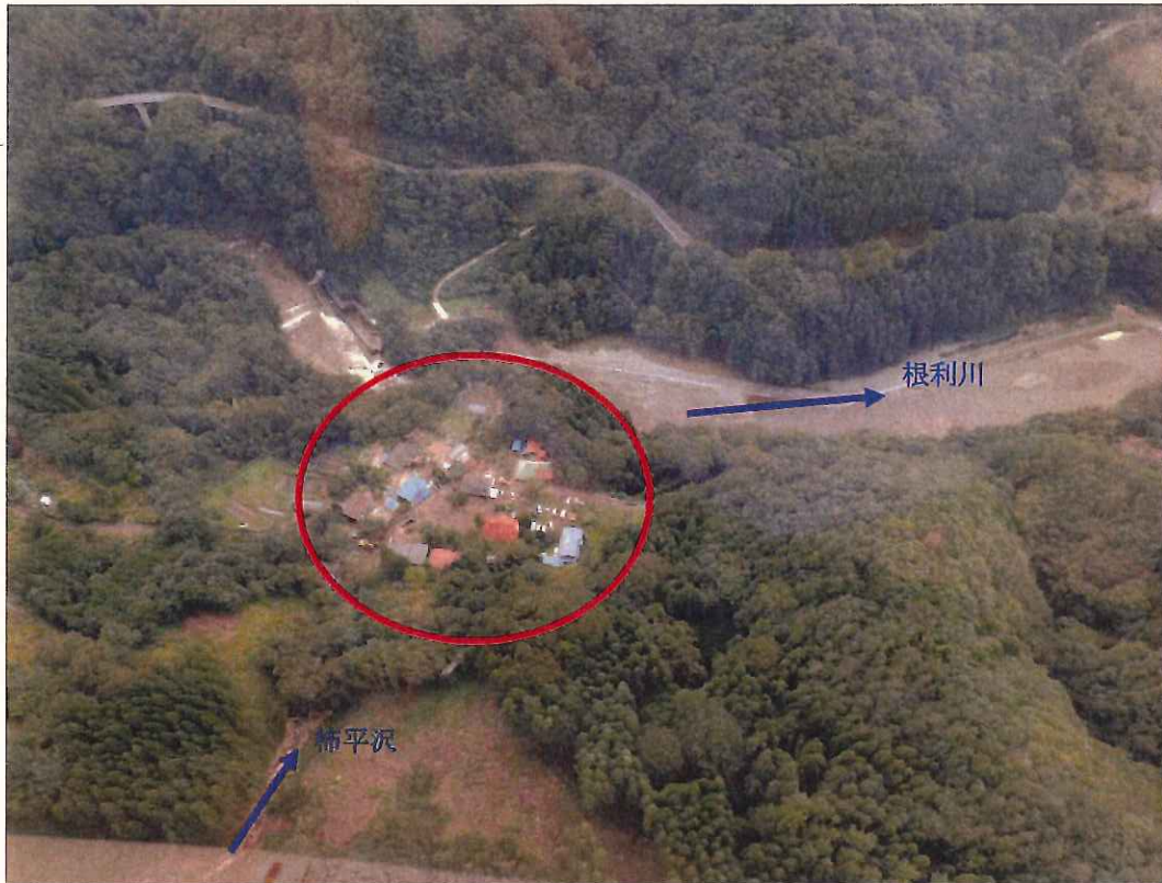
柿平地区被災状況
