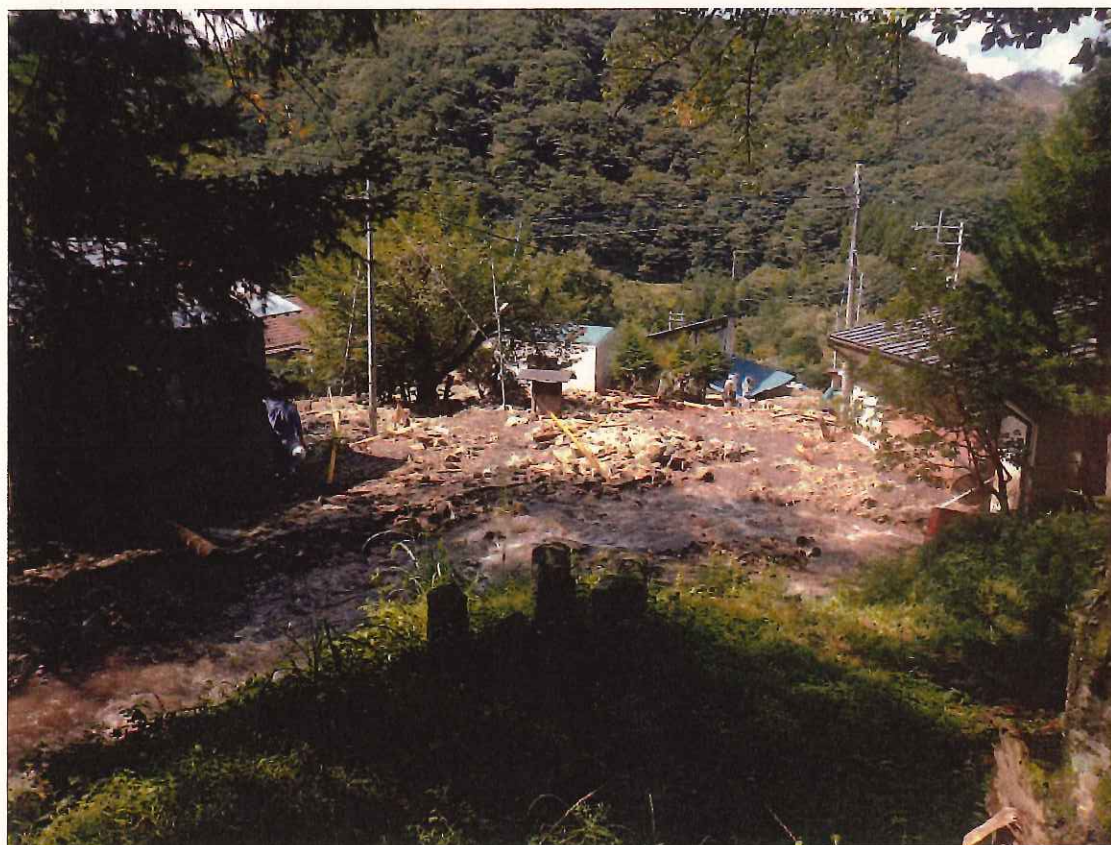
柿平地先土砂はん濫状況(上流より下流を望む)
