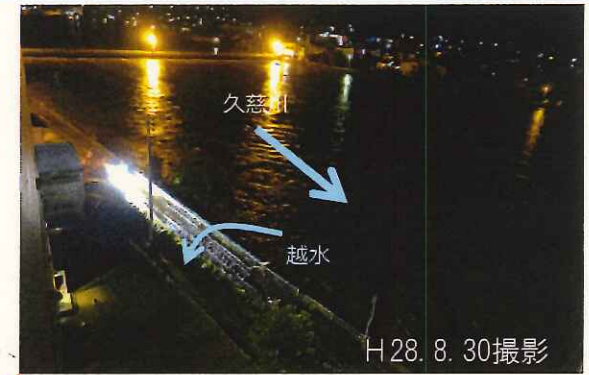
久慈川(右岸)越水状況
