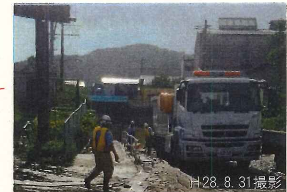
久慈川 排水作業状況 (8/31 排水作業完了)
