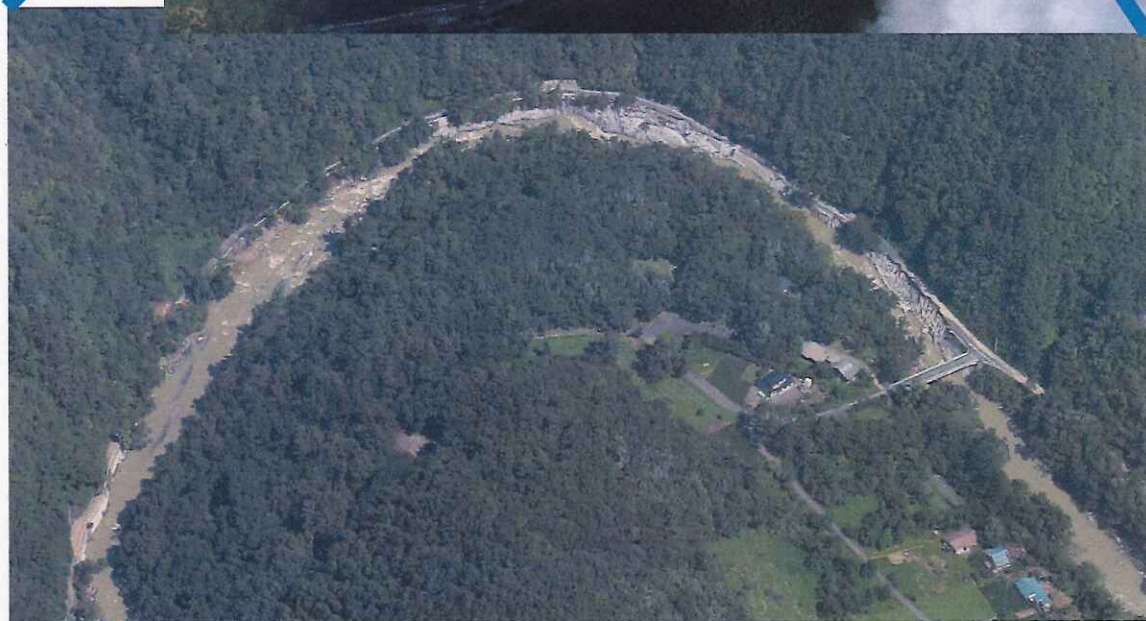
河川沿いの県道が 複数地点で崩落
