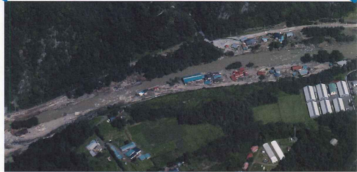
安家川沿いの住宅に流木が流れ込んでいる
