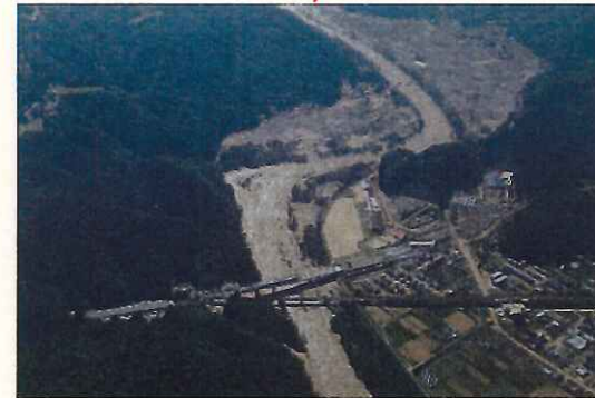
岩泉町下流浸水状況
