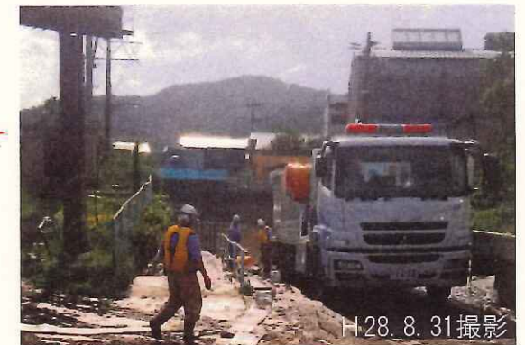
久慈川 排水作業状況
