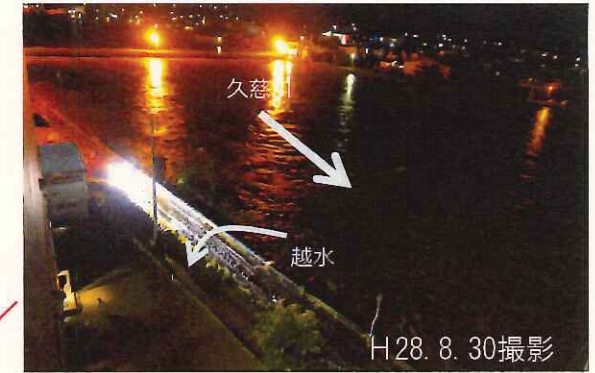
久慈川(右岸)越水状況
