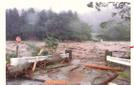
鶴住居川出水状況
