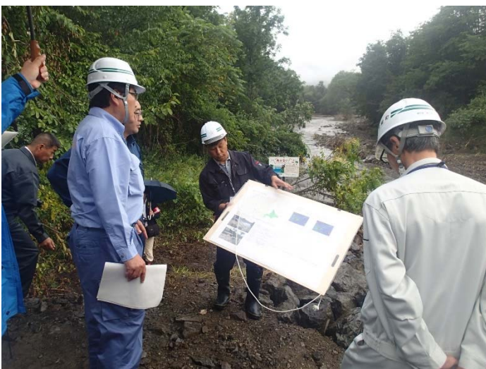
町道橋落橋現場状況調査 【遠軽町内】
