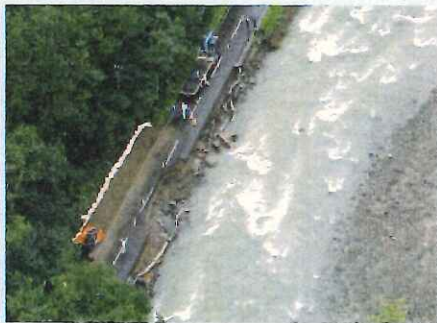
天人峡道路流出(東川町)
