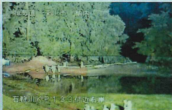
排水作業 状況
