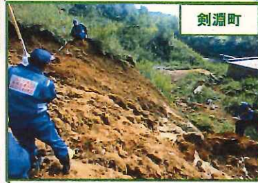
被災状況調査(剣淵町)
