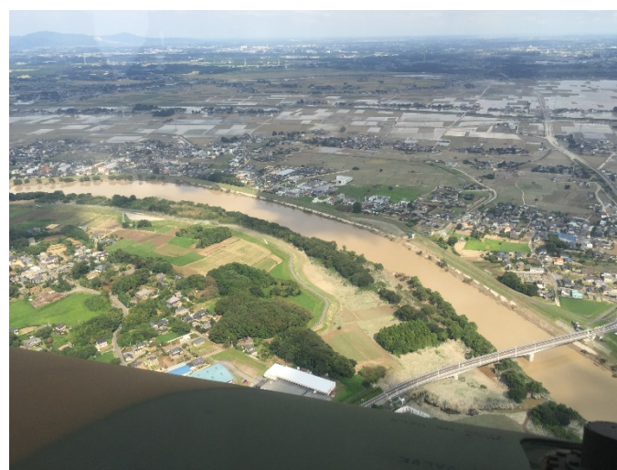
堤防決壊により被災した市内の様子② 【茨城県常総市内】
