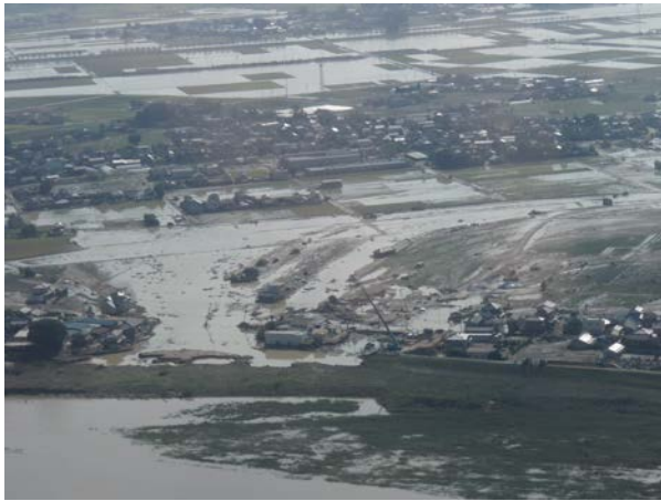
上空からの被災箇所（鬼怒川破堤箇所） 【茨城県常総市】
