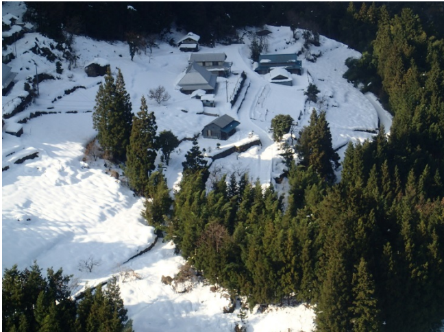
ヘリによる上空視察②（大雪被害を受けた集落の状況②） 【徳島県内】
