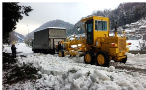
除雪車両による車両牽引状況
