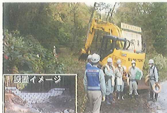
堰堤設置作業に着手 (10/4)
