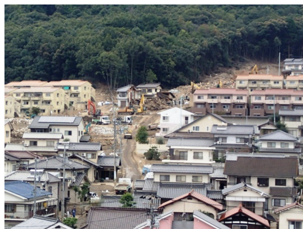
重機等による復旧作業の様子【広島市安佐南区八木地区】
