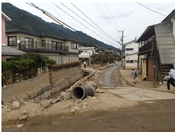
土砂撤去により通水機能を確保した用水路周辺の様子【広島市安佐南区八木地区】
