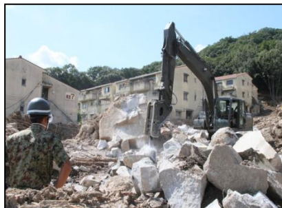
重機による岩石の掘削
