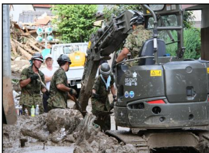
重機による土砂撤去
