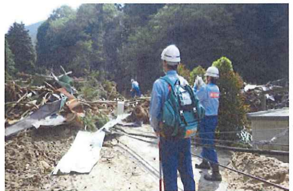
TEC-FORCE による点検状況
