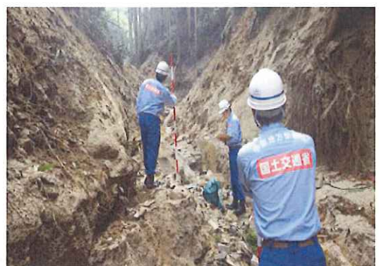
TEC-FORCEによる点検状況
