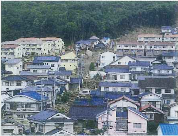
土砂災害現場① 【広島県広島市安佐南区八木地区】
