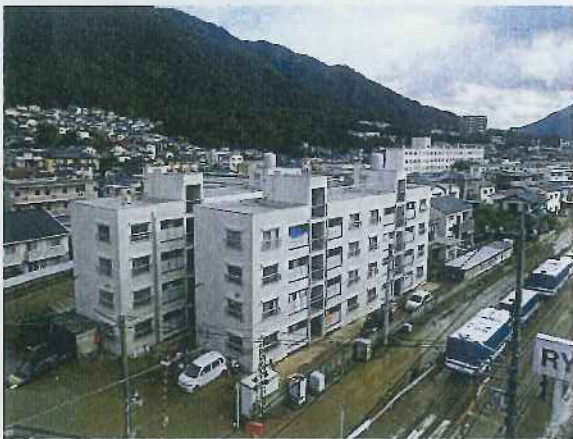
土砂災害現場③ 【広島県広島市安佐南区八木地区】
