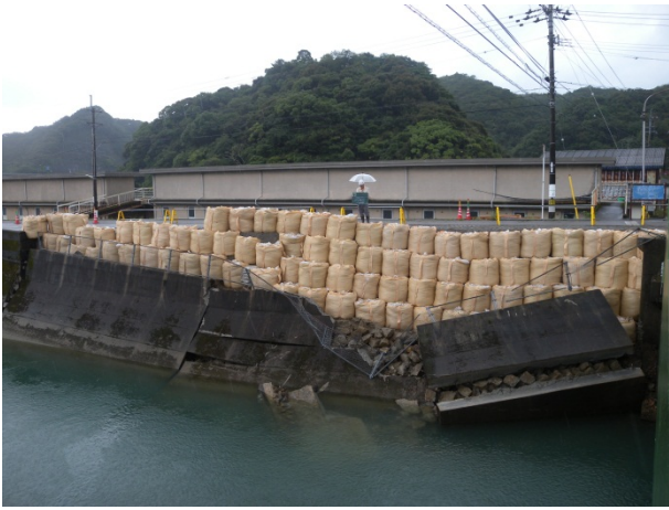
被害を受けた穴喰川護岸の仮復旧の様子 【徳島県海陽町穴喰地区】
