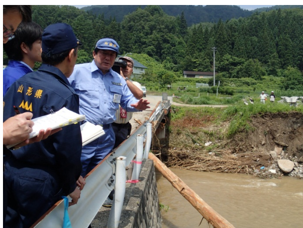
被害状況の説明を受ける亀岡政務官 【南陽市白山在家地区】
