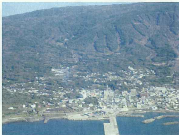
土砂崩れの状況を上空から調査【大島町】
