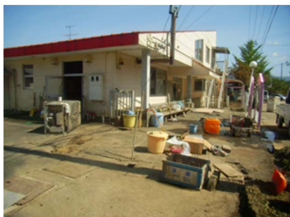
浸水被害を受けた保育園【盛岡市玉山区】
