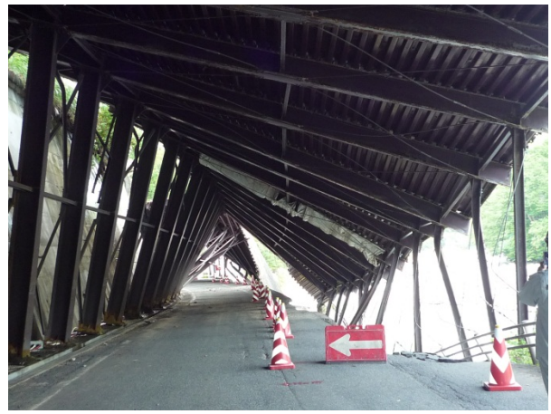
被害を受けた国道341号線のスノーシェッド (雪崩よけ)【仙北市田沢湖玉川地区】
