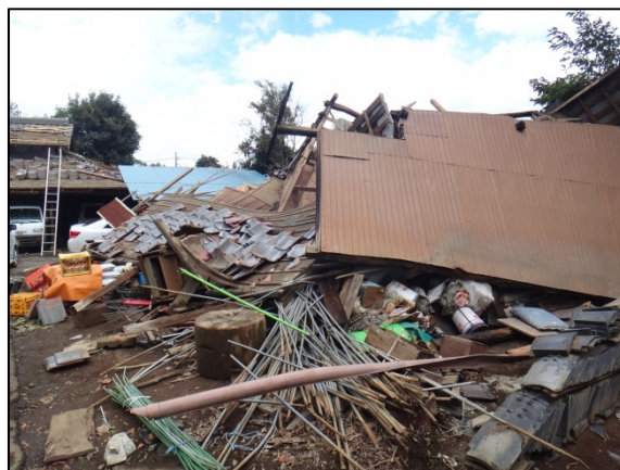
住宅被害の様子 【千葉県野田市谷津地区】
