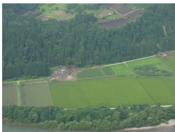
土砂流入による農道被害を調査【秋田県鹿角市】
