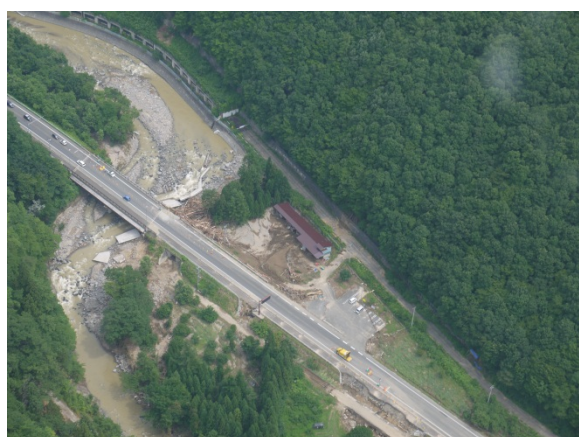
国道46号線の路面崩落を調査【岩手県雫石町】
