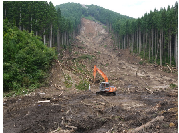
土石流による被害の様子①【同】
