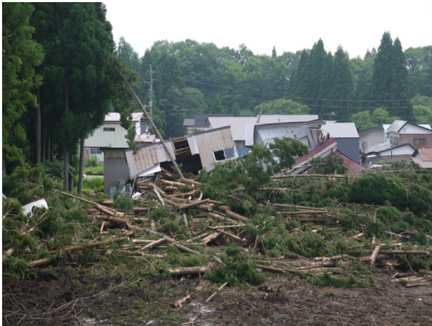
土石流による被害の様子②【同】
