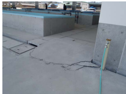
荷捌き場の段差を調査【淡路市生穂漁港】
