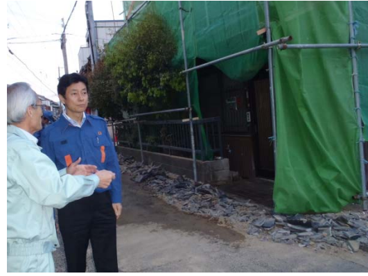
市街地の住家の被災状況を調査 【洲本市内（炬口地区）】
