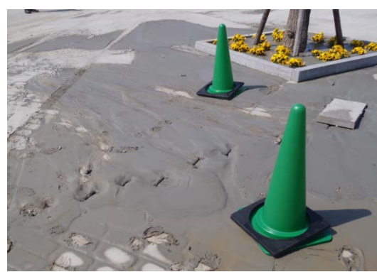
液状化の状況を調査 【淡路ワールドパークONOKORO】
