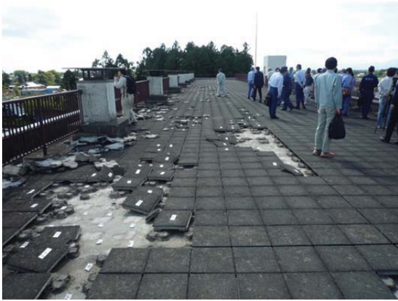
↓ 栃木県真岡市立西田井小学校を現地調査する中川防災担当大臣
