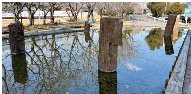
液状化により地上に現れた旧相模川橋脚
