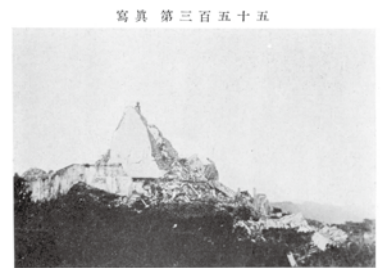
千葉県安房郡野島崎 野島燈台倒壊状況(其一) (四角より見たる光景)
