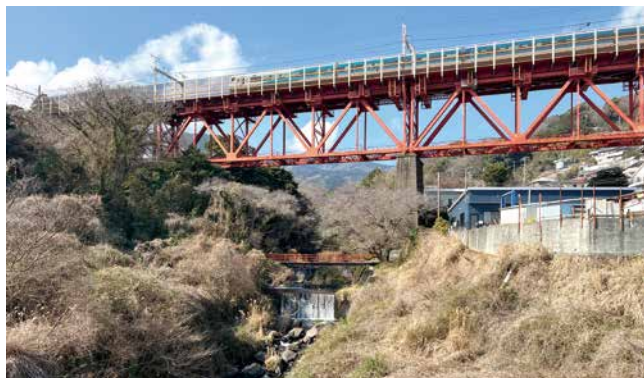
岩屑なだれが下った白糸川（土木学会附属土木図書館提供・写真上）と現在の様子（写真下）
