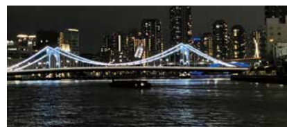
左岸上流側の隅田川テラスからの清洲橋の夜景。右橋に永代橋のアーチが青く浮かぶ
