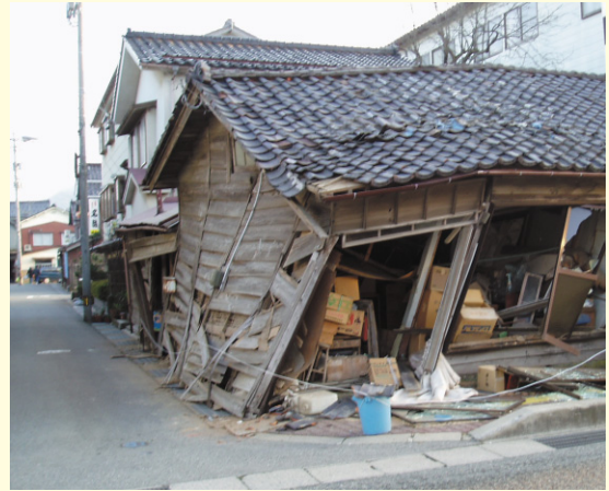
■輪島市の被害状況
