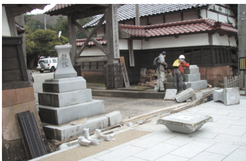
■総持寺（門前町）の被害状況
