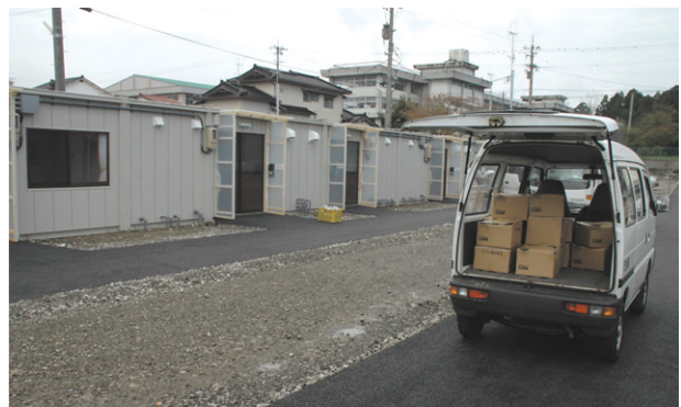
■輪島市に開設された仮設住宅
