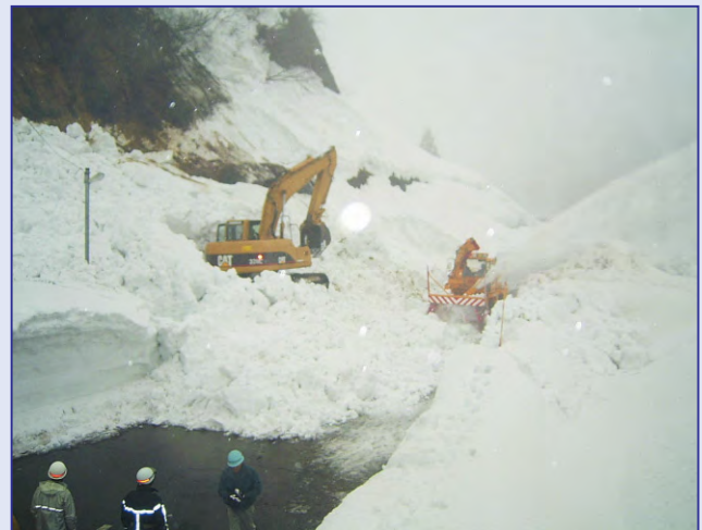
■雪崩発見からおよそ4時間後の午前10時半に排雪作業を完了
