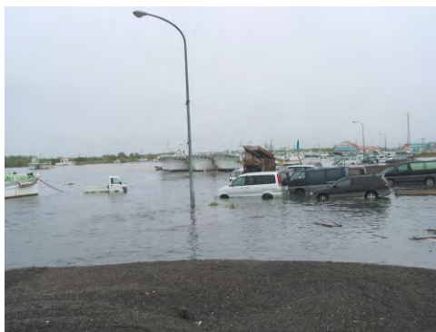
■十勝沖地震時の被害(豊頃町大津漁港)
