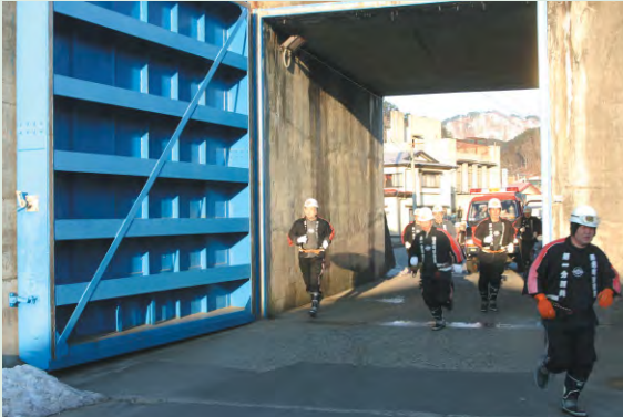
■消防団による防潮堤水ひ門閉鎖訓練 震度3以上の地震発生と同時に駆けつけ、発生から5分以内を目標に111箇所の水ひ門の閉鎖を完了する。
